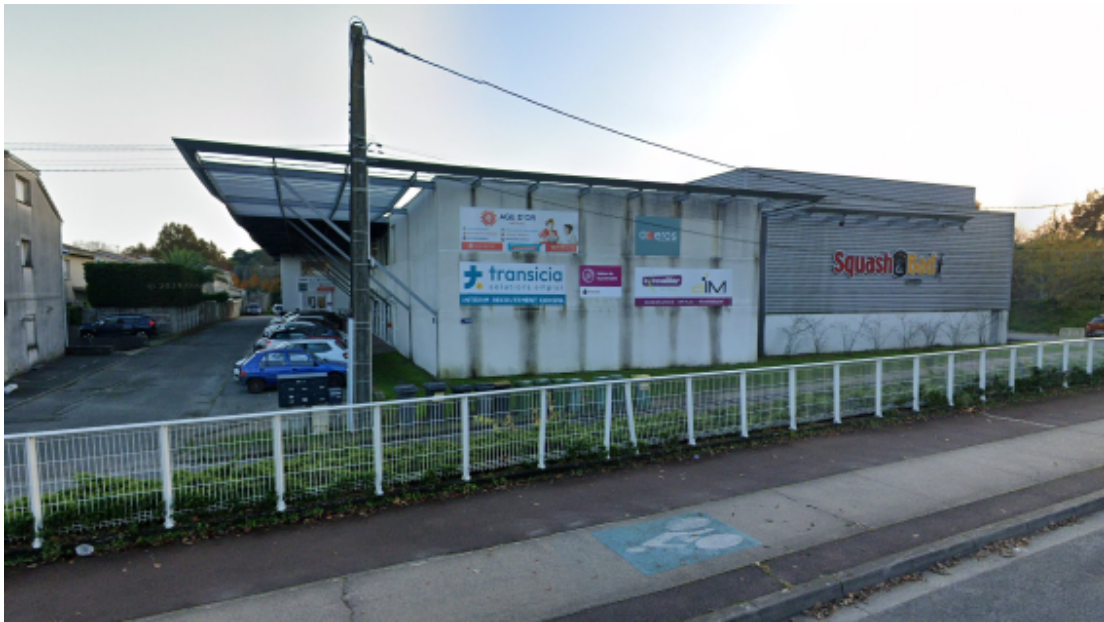
FIGURE 3 – Bâtiment hébergeant entre autres les entreprises Akeros et FlyRénov
